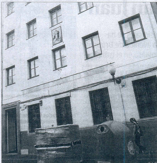
Imagen del edificio que acogerá el área de Ginecología. (SABEL RAMÓN)
