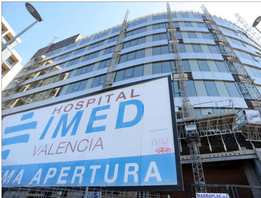
Las obras, ayer, del hospital IMED de Burjassot que muestran su avance importante. MAO
