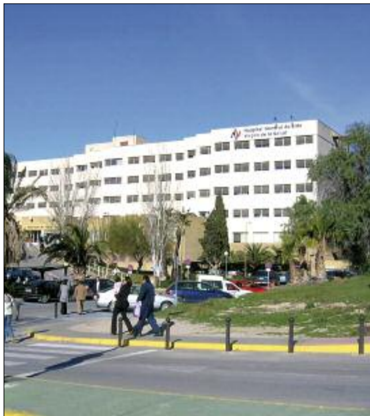
Vista general del Hospital de Elda.
